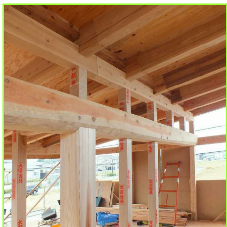
24センチ角の大黒柱と丸太梁
