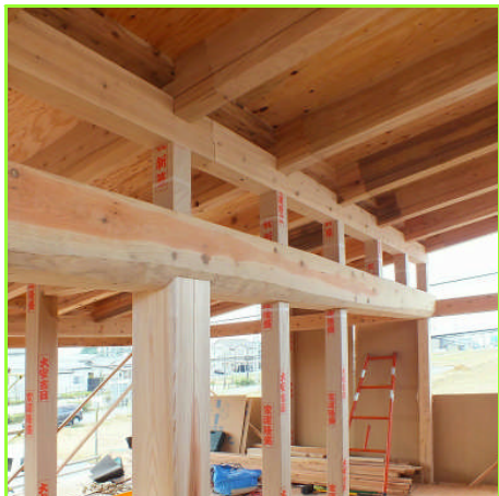
24センチ角の大黒柱と丸太梁
